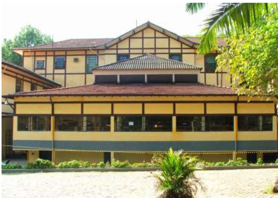
Figura 34. Fachada principal do Aquário Água Branca revitalizada e o patrimônio histórico recuperado (Foto: 2005).
