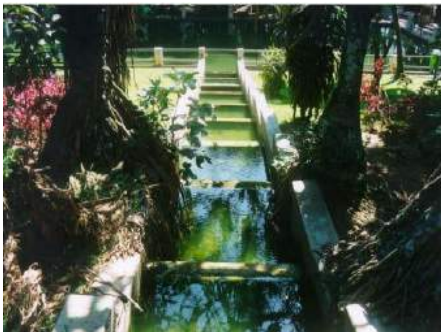
Figura 7. Interligando os dois tanques existe uma escada com 10 degraus (1,50x1,50 m), com um desnível total de 2,5 m sendo 0,25 m entre cada degrau (Foto: 2017).
