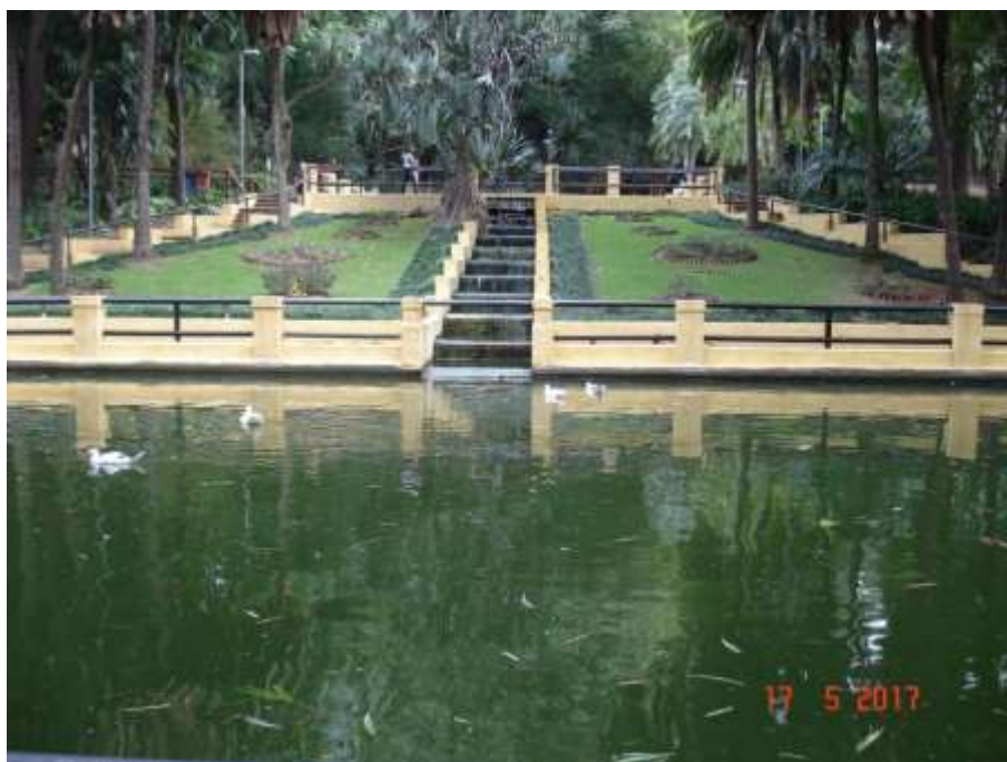
Figura 5. Conjunto de estruturas conhecidas como “Escada de Peixes” no Parque Fernando Costa composta de dois tanques de alvenaria (superior e inferior), interligados por uma escada (Foto: 2017).
