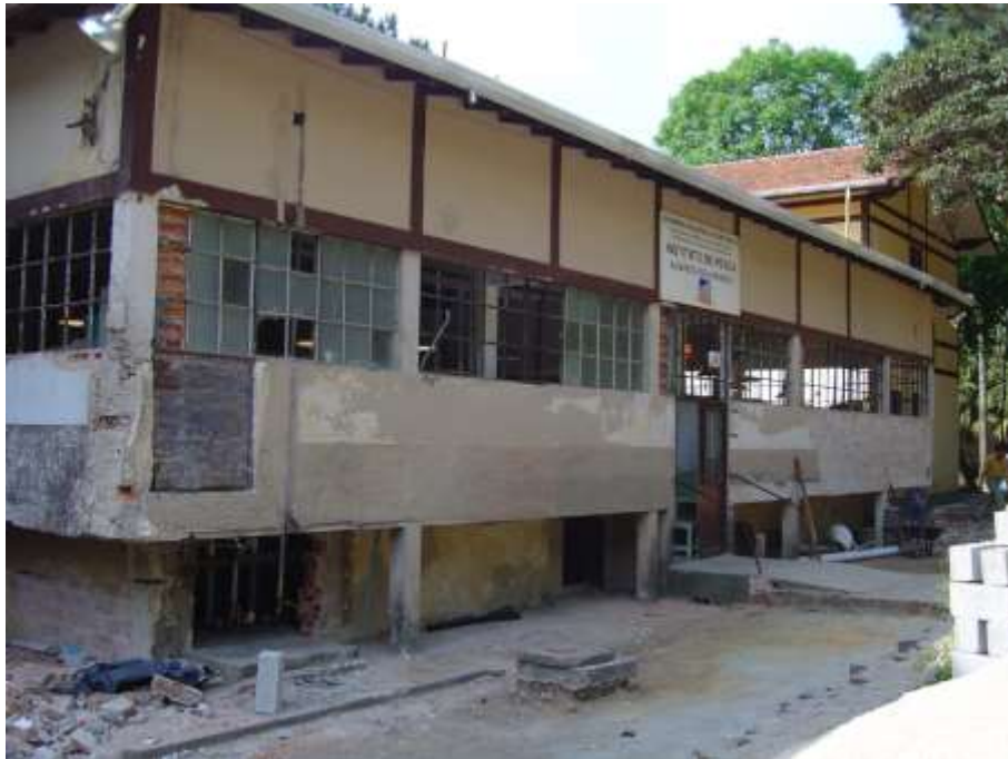
Figura 32. Revitalização da fachada do Aquário Água Branca, onde todas as estruturas elétricas e hidráulicas provisórias foram removidas (Foto: 2004).
