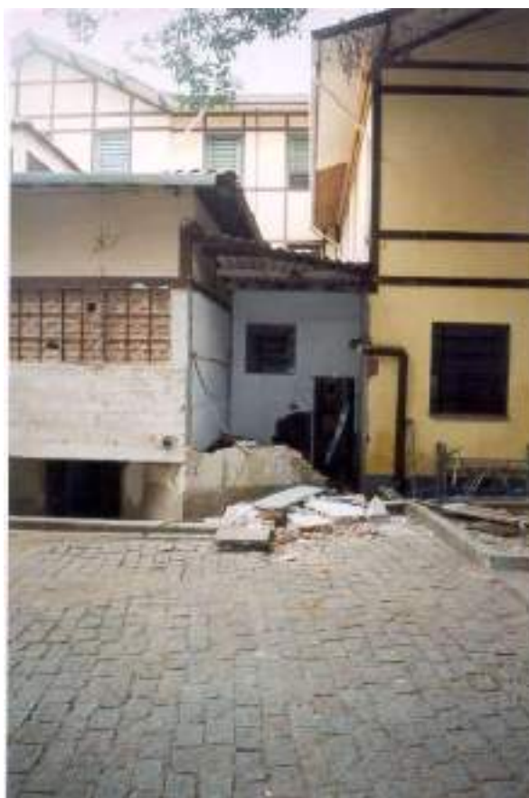
Figura 28. Início das demolições de estruturas provisórias no local onde atualmente é a entrada do Aquário Água Branca (Foto: 2004).
