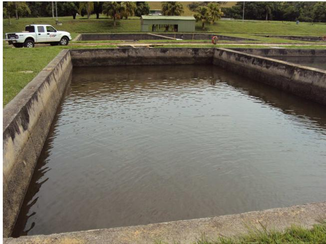
(G) Tanques escavados - 200 m<sup>3</sup> (20 X 10 X 1 m)
